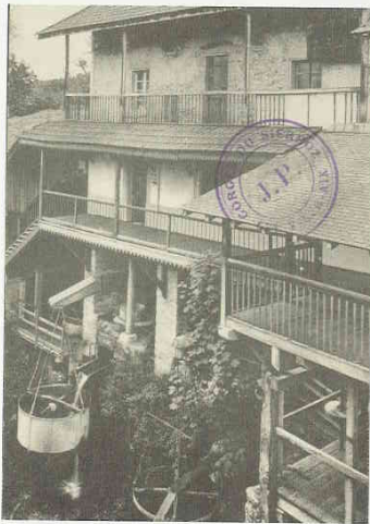
Moulin de Salauz : les 2 presses et leurs cuves suspendues au-dessus du canyon (XX e siècle). Collection Association Au Cœur des Gorges du Sierroz.
